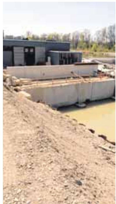
Das Wasserkraftwerk in der Firnhaberau gilt als ökologisch vertretbar. Foto: wys
