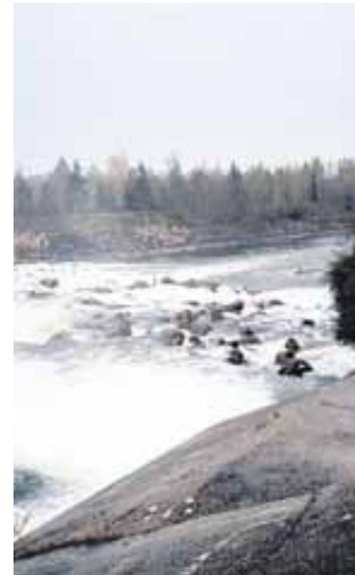
Am Lech auf Höhe von Kissing ist das Wasserkraftwerk beantragt. Foto: Kaya
