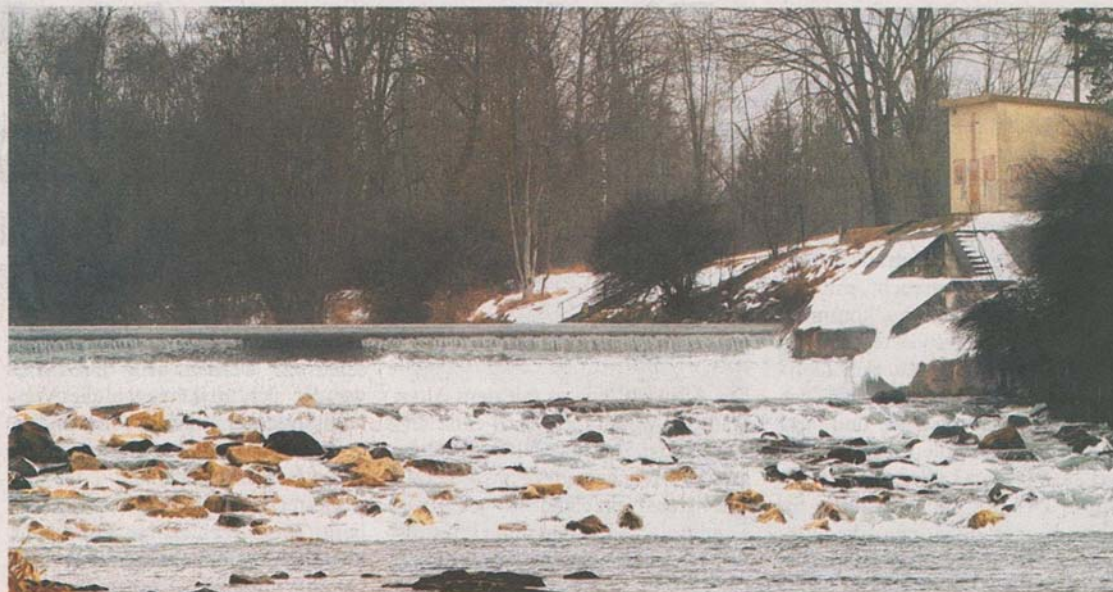
An dieser Schwelle soll das neue Wasserkraftwerk am Lech entstehen. Das Projekt hat viele Gegner. Sie wollen stattdessen einen naturnahen Ausbau des Flusses. Dafür macht jetzt auch eine Parlamentariergruppe im Bundestag mobil. Foto: Kaya
