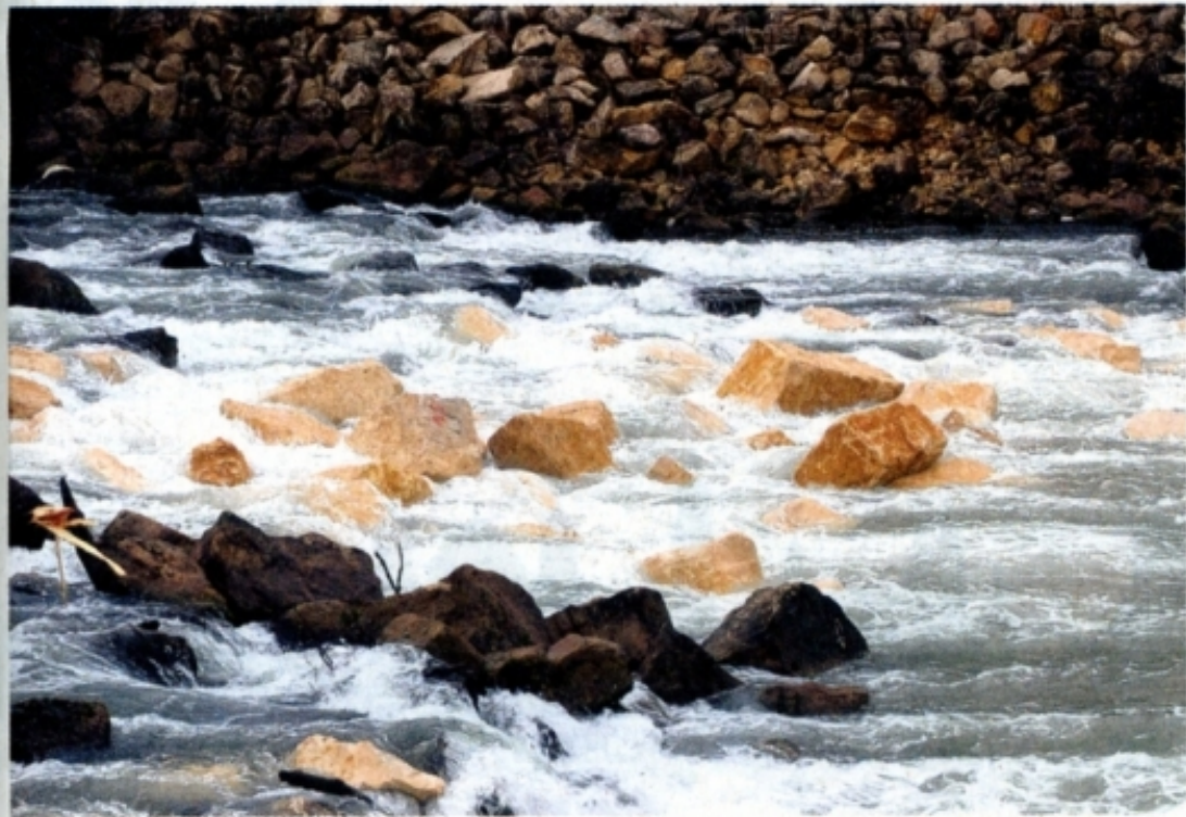
Die Ufergestaltung der neuen Stauseen leidet erheblich durch den Schwellbetrieb, so der Vorwurf der Lechallianz an den Kraftwerksbetreiber.
