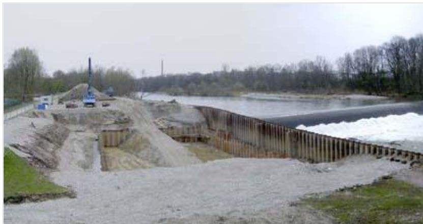
Im Bau: Kraftwerk an der Wolfzahnau (Panorama zum Vergrößern anklicken)
